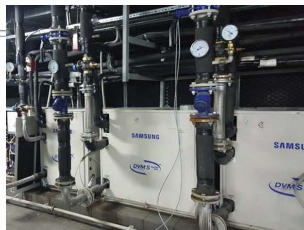
Рис. 3. Наружные блоки DVM S Water установлены в техническом помещении цокольного этажа вокзала
